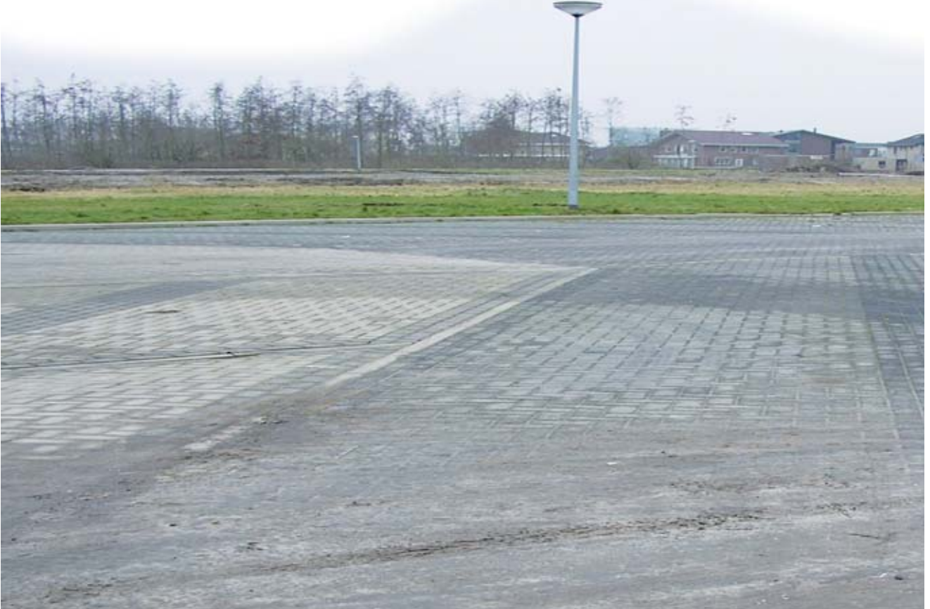
Figuur 3: Dichtgeslibde doorlatende verharding
