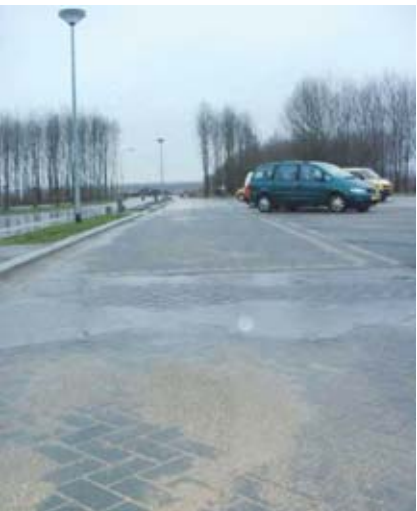
Figuur 2: Traditionele verharding en doorlatende verharding tijdens regenval
